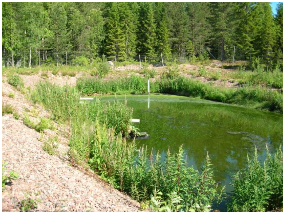
Fryksås avloppsanläggning (allmän va-anläggning). Foto: Klas Jonsson. Länsstyrelsen i Dalarna.
