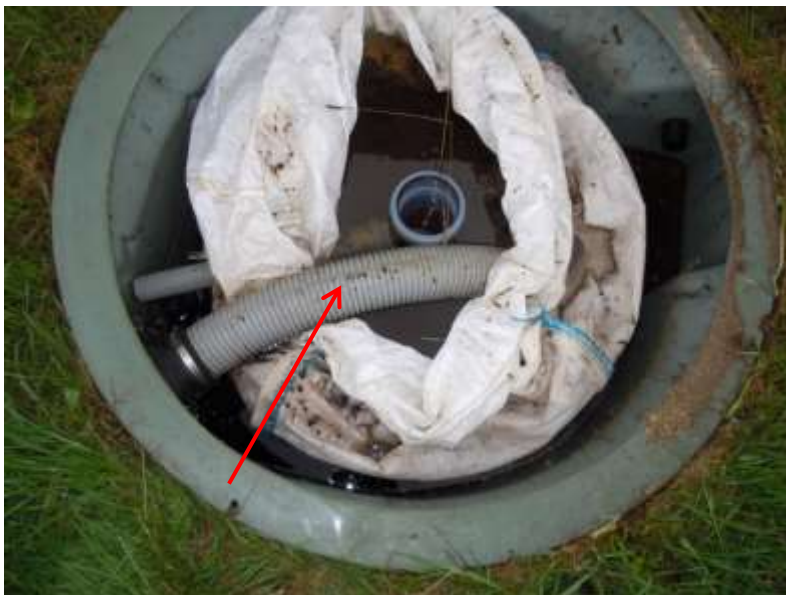
Bild 7 Fosforfälla med "bakfall" på inloppsöröret.
