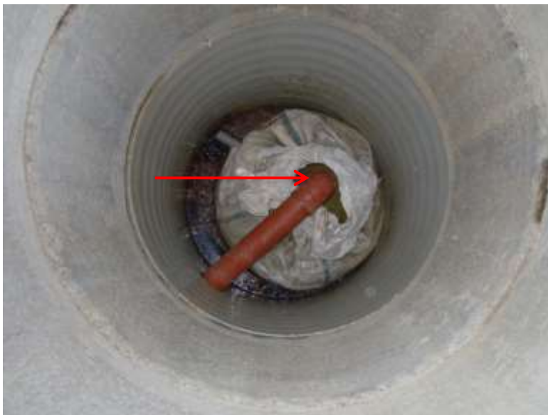
Bild 9 Felinstallerad säck. Modell 1.0 kopplad som modell 1.1.
