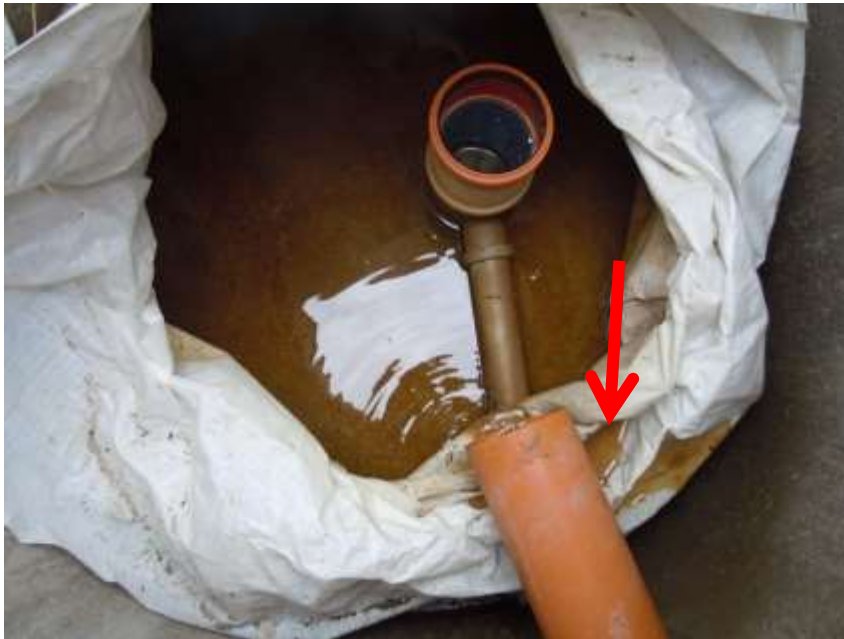
Bild 12 Säcken något felplacerad i brunnen, för kort rör eller säck ej uppvikta ordentligt? Resulterar i att en del vatten hamnar utanför filtret.
