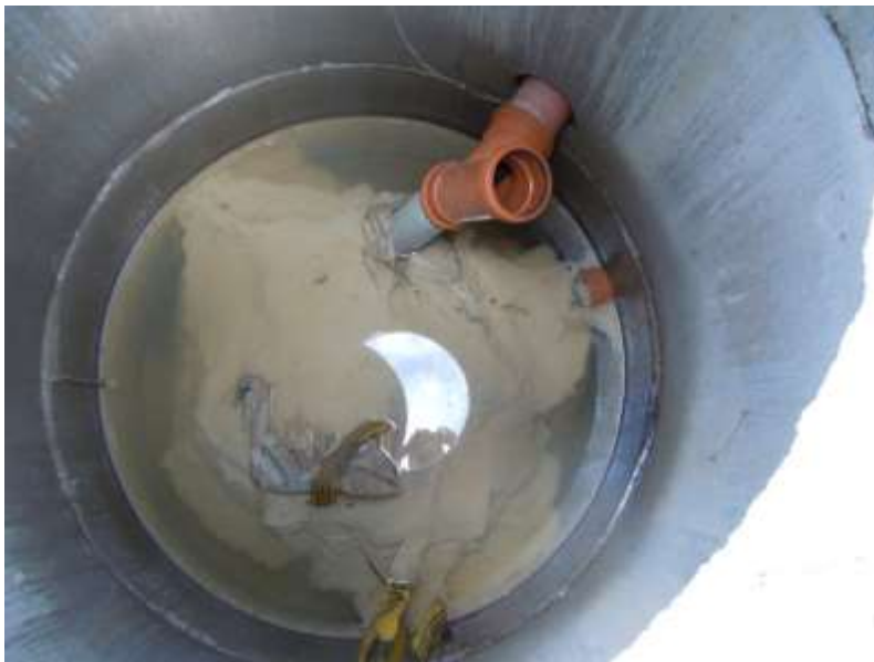
Bild 5 Översvämmad säck med grumligt vatten. Går ej att se vilken typ av modell på säcken.
