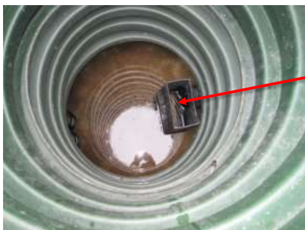
Bild 3 Provtagningspunkt på fosforfälla med lös filtermassa.
